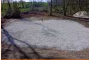
"Hérisson" de pierre pour installer la plateforme bois
